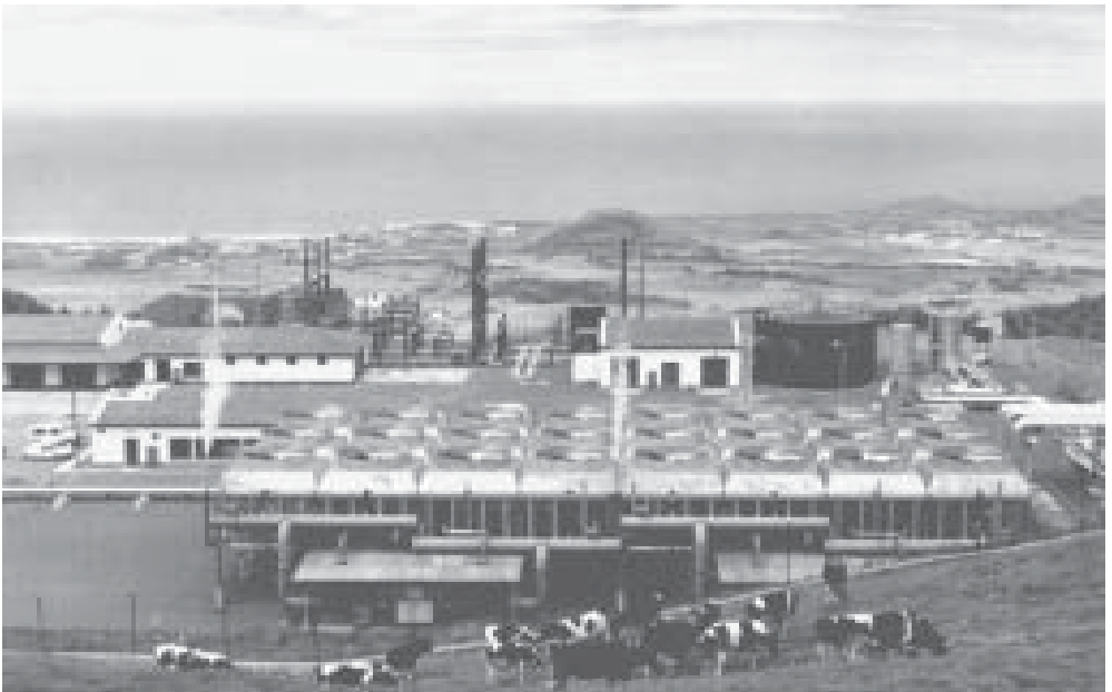
Figura 2. Central geotérmica da Lagoa do Fogo, ilha de S. Miguel, Açores (SOGEO, S.A.).
