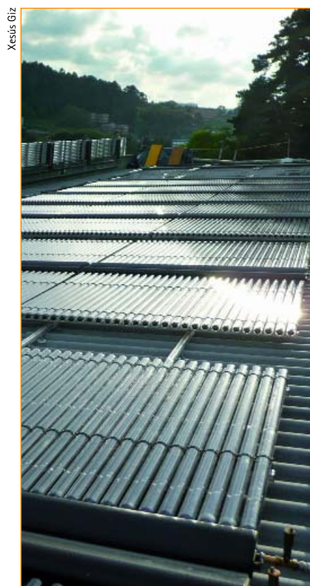
Instalación de enerxía solar térmica na FCDEF-UDC. A tecnoloxía empregada é a de tubo de baleiro de fluxo directo (en total 140 m²) con disposición en cuberta e en fachada.
