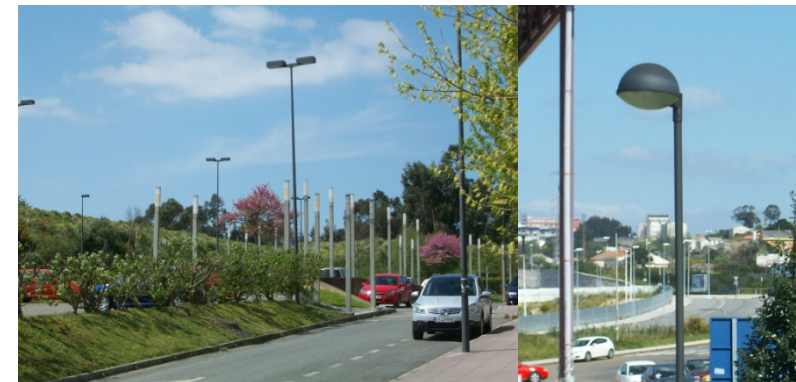
Ilustración 31: Fotos da iluminación pública
