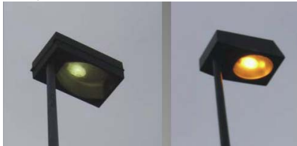
Ilustración 29: Fotos de lámpada de VM (esquerda) e de vapor de sodio (dereita) Fonte: Elaboración propia
