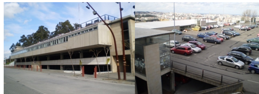
Ilustración 32: Fotos dos aparcadoiros do campus da Zapateira Fonte: Elaboración propia
