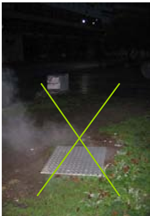
Perdas de calor nas tubarías soterradas
