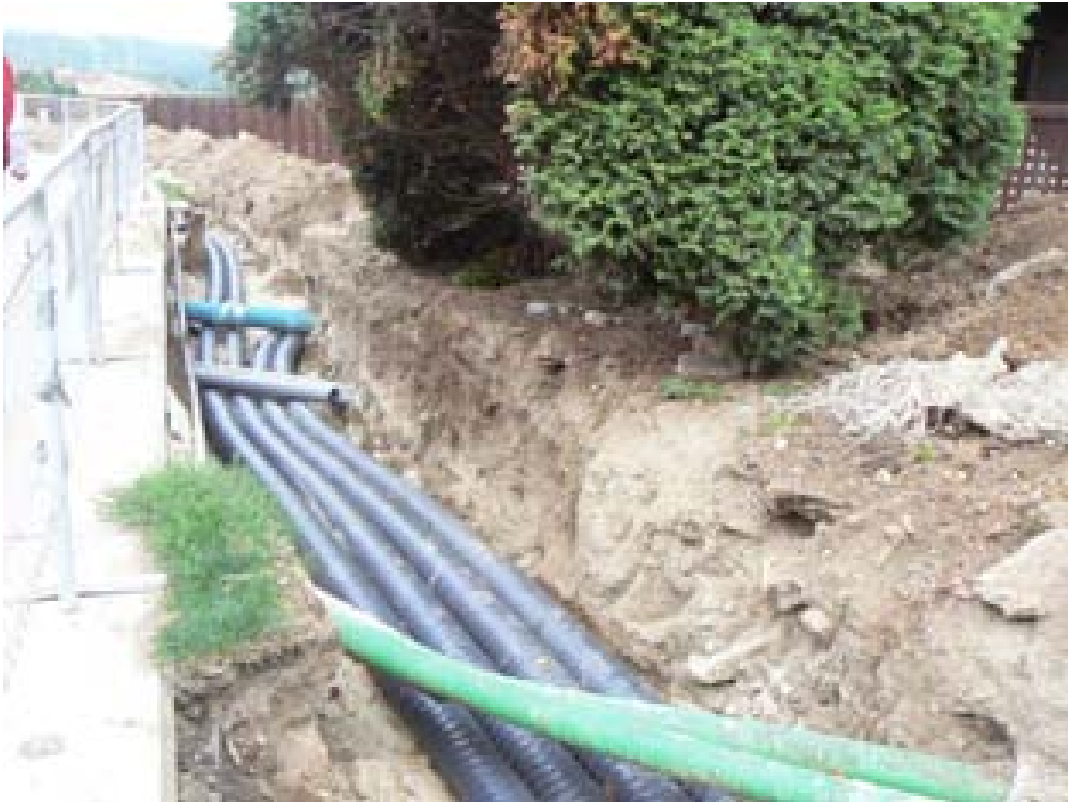
Novas tubarías instaladas
