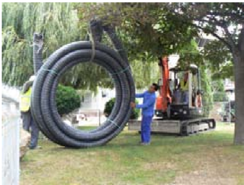
Montaxe de novas tubarías soterradas
