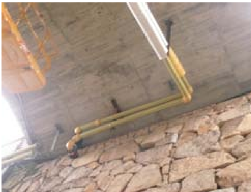
Montaxe de novas tubarías Baixo a pasarela da ETSA
