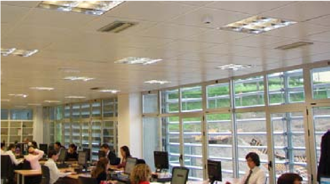
ULTIMA TIRA DE LAMA DE REGULACIÓN SOLAR PECHADA CANDO O SOL NON INCIDE DIRECTAMENTE SOBRE ESA FACHADA E 100% DA ILUMINACIÓN ACCESA
