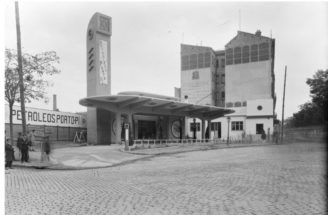
En Coruña tuvimos como ejemplo paradigmático la Estación de Servicio de Cuatro Caminos, de Antonio Tenreiro y Peregrín Estellés, construída en 1934 y demolida posteriormente. Se trata de un edificio entre medianeras con dos grandes arcos entre los que entraban y salían los vehículos para repostar, cambiar neumáticos y limpiarse. Sigue el mismo esquema funcional, de una zona de servicio cerrada y frente a ella otra cubierta pero abierta donde paran los coches.
