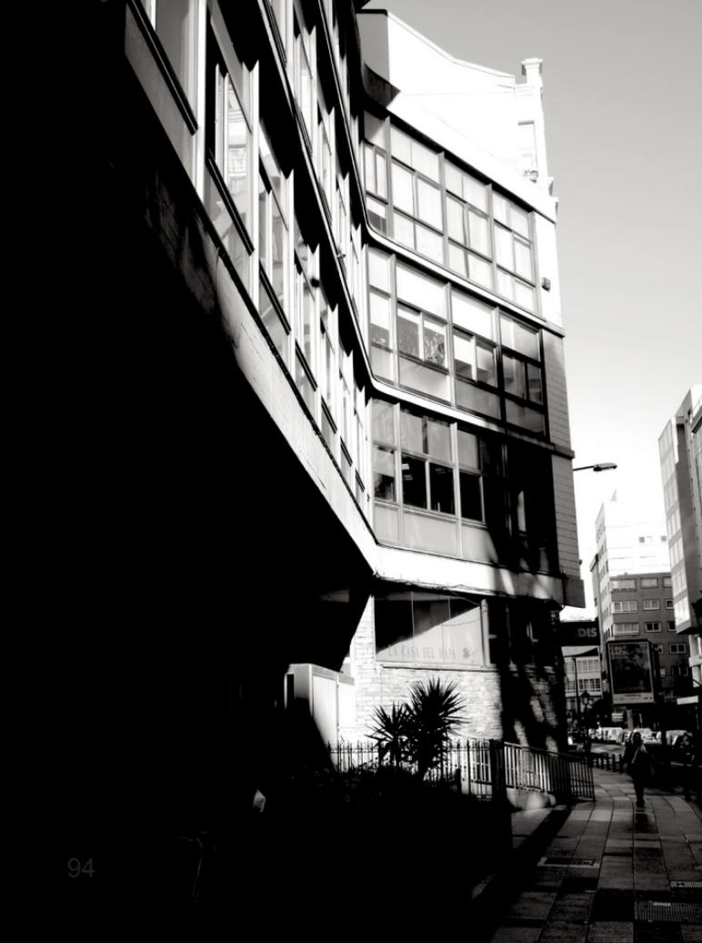
Constructivamente el edificio está formado por un esqueleto de hormigón armado que se completa con los ya citados muros cortina de cerramiento. La estructura reticular y ordenada permite que todos los elementos se rijan por el mismo módulo. De esta forma, se repite un único diseño de carpintería en todo el edificio, lo que permite ahorrar costes y facilitar la construcción, como si se tratara de piezas de un automóvil dispuestas a ser ensambladas en una cadena de montaje.
