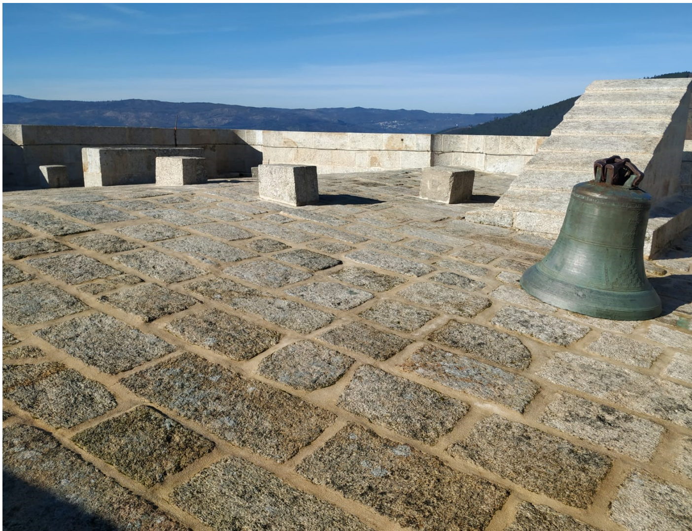
Fig. 52 fotografía da parte superior da Torre Nova en Monterrei Procedencia: 40
