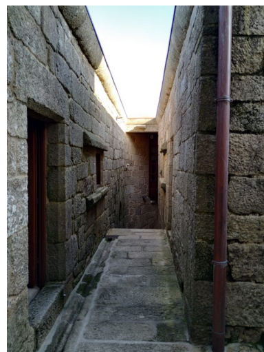
Fig. 46 rúa interior Sobroso Procedencia: 46
