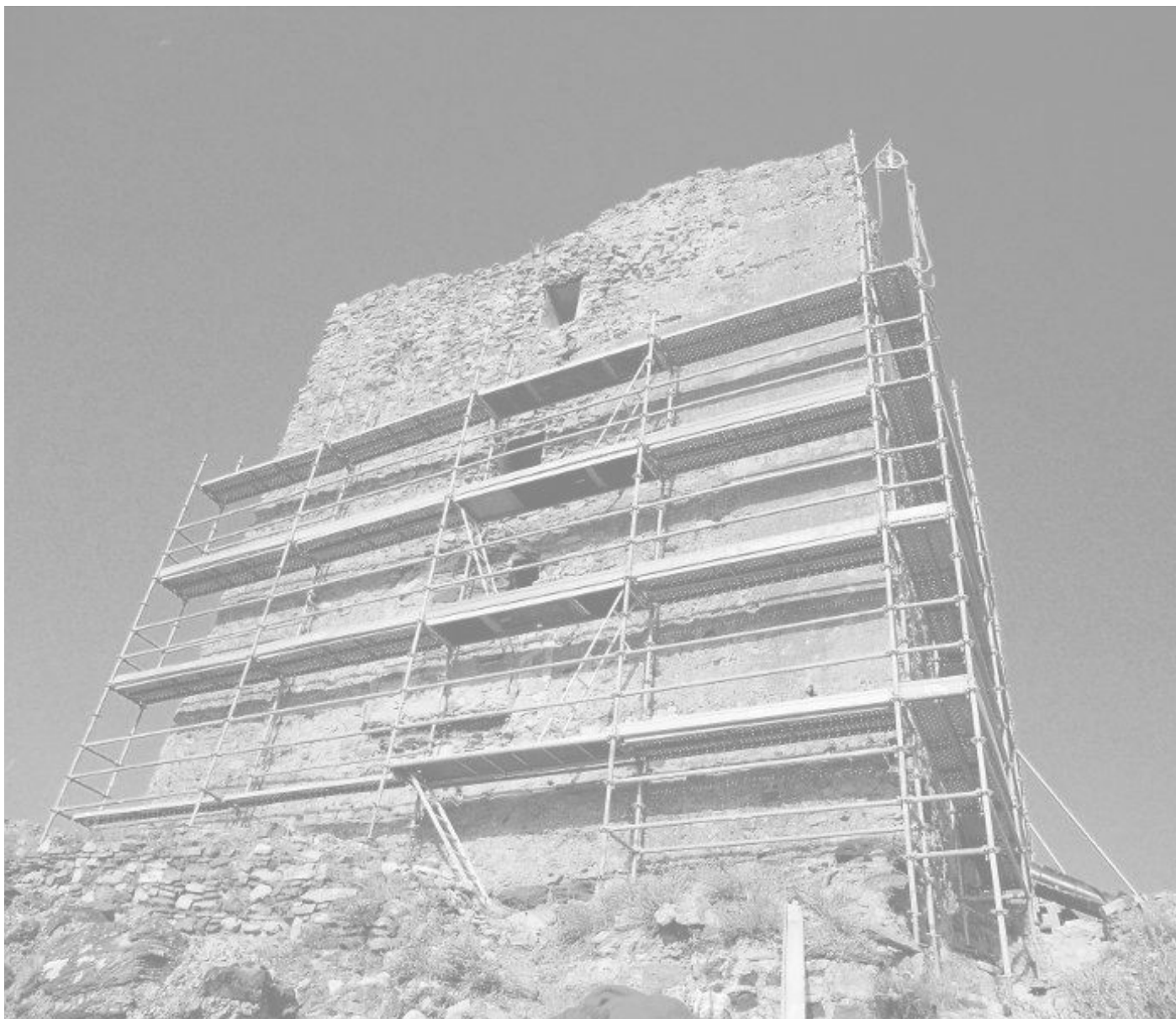
Fig.23 Restauración dunha Torre da Homenaxe Procedencia: 21
