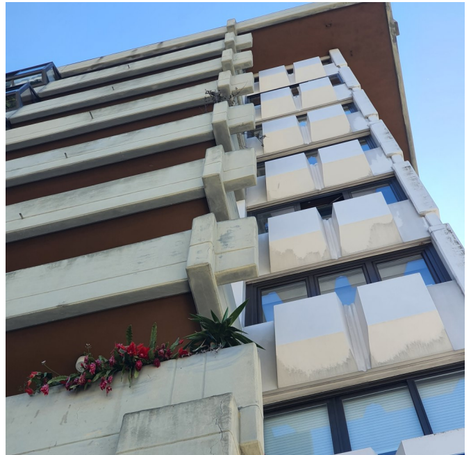
Fig. 32. Fotografía dos encontros nas varandas do edificio Petroliber
