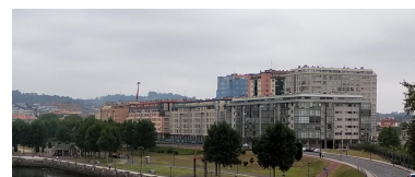
41_Vista xeral dos edificios de vivendas nos antigos terreos da Cros.
