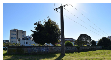
70_O muro de contección e límite da zona de ocio.
