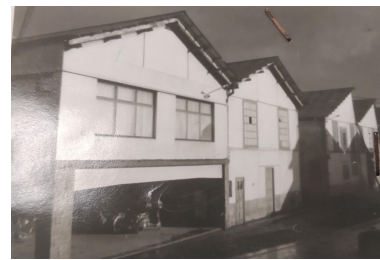
20_Talleres e almacéns na fábrica da Cros, no 1965.
