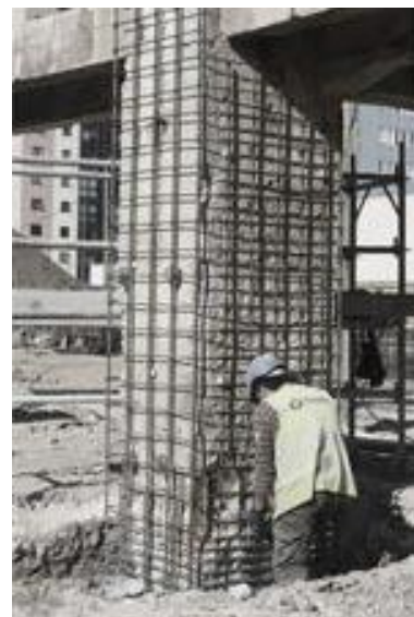
62_Reforzo da estrutura.
