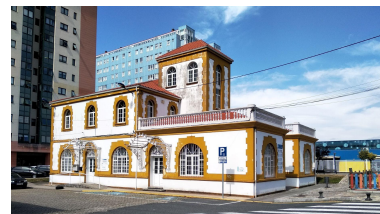
57_Antigo edificio de oficinas, despachos e laboratorio.
