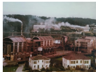
27_A fábrica da Cros en funcionamento.
