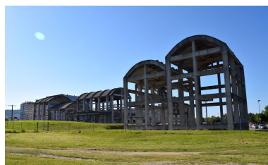
64_As naves rehabilitadas.
