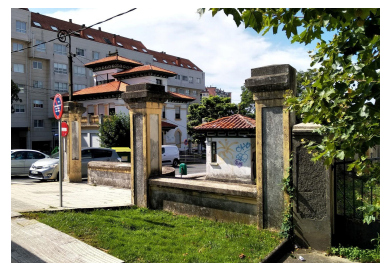
68_Antigo cerramento no acceso dende a AC-211.
