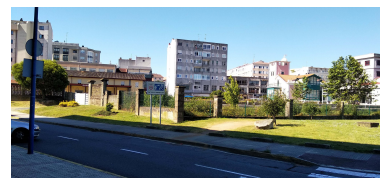
66_Muro de peche do recinto da fábrica, no antigo aparcadoiro do tren.
