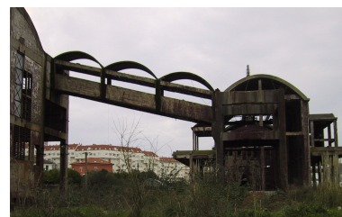
60_As naves sen rehabilitar 02.
