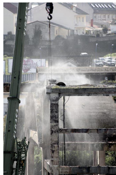
61_Rehabilitación e descontaminación da estrutura.
