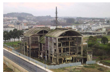
59_As naves sen rehabilitar 01.
