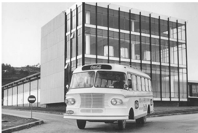
5.01 Edificio de fábrica y oficinas de la Coca-cola Andrés Fernández-Albalat y Antonio Tenreiro Brochón
