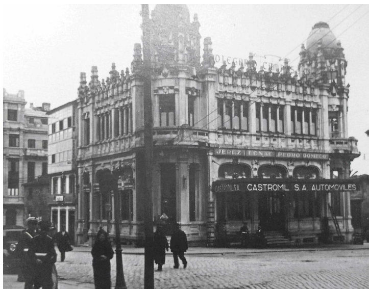
6.01 Imagen del antiguo edificio Castromil, previamente conocido como café Quiqui-Bar. Derribado en el año 1975 y situado en la plaza de García Priet, hoy plaza de Galicia.
