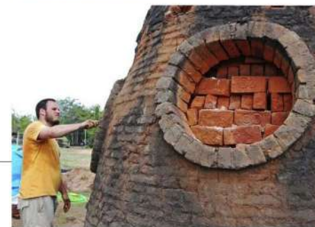
Ladrillos fabricados in situ con la tierra del lugar y horneados en el propio edificio.
