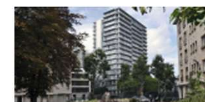
Transformation de la Tour Bois le Prêtre Paris 17 - Druot 2011
