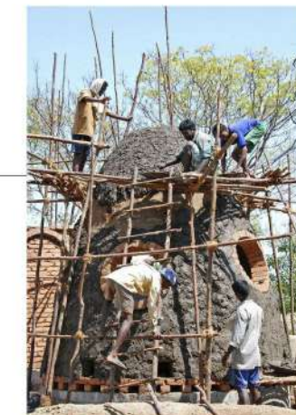
Recubrimiento del interior y exterior utilizando la técnica de rangoli, que es una técnica tradicional india.
