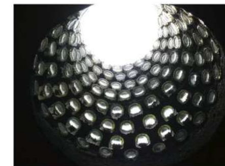
Cerramiento de la cubierta utilizando botellas de vidrio recicladas.
