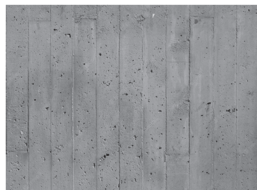
MUROS DE HORMIGÓN TEXTURIZADO
