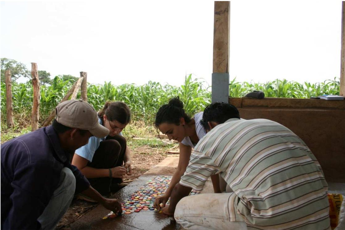
Se terminó el acabado final de cal que lo protegerá de las inclemencias del clima y mientras dejábamos secar la primera mano del repello de los paneles, nos dispusimos a colocar el suelo de tapones. En esta tarea colaboramos todos, ya que nos hacía ilusión ir colocando los tapones de colores a modo de mosaico. Quedamos más que satisfechos con el resultado, veremos que opinan nuestros compañeros en la próxima inauguración.
