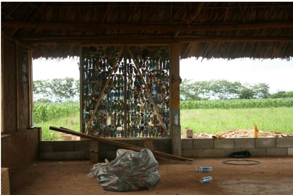
Cumpliendo con la agenda terminamos de montar el último panel previsto, que contempla un sistema distinto, que va apoyado directamente sobre dos hiladas de bloc, con paneles de 1.90m de altura y diagonales para rigidizar. Ahora sólo falta repellarlos y preparar la silueta de quetzal que quedará vista como muestra de las botellas que lleva en su interior.
