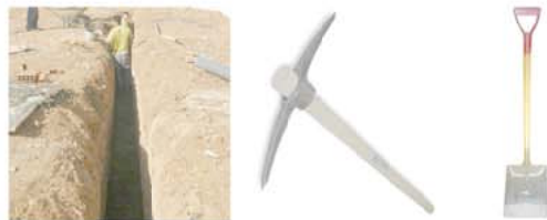
2 apertura de las zanjas
