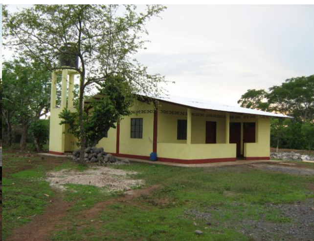
Mª del Mar sector 1: Edificio comunal
