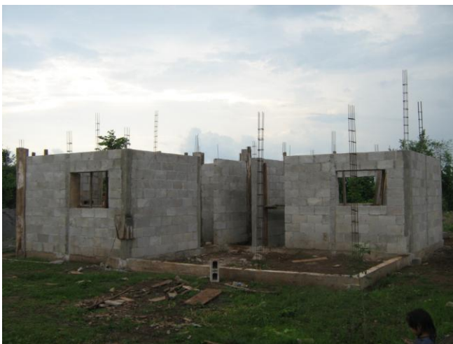
Vivienda en construcción
