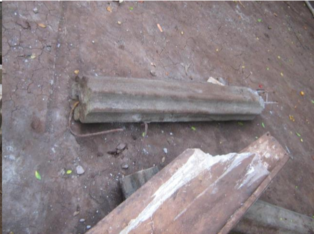
Curiosos piares encofrados con chapa ondulada metálica
