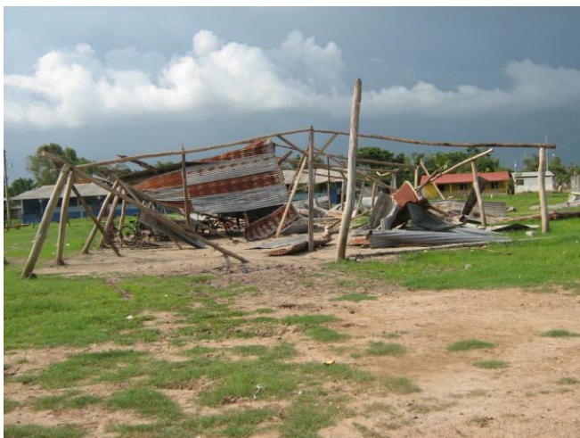
Espazo comunal destruído polo furacán.
