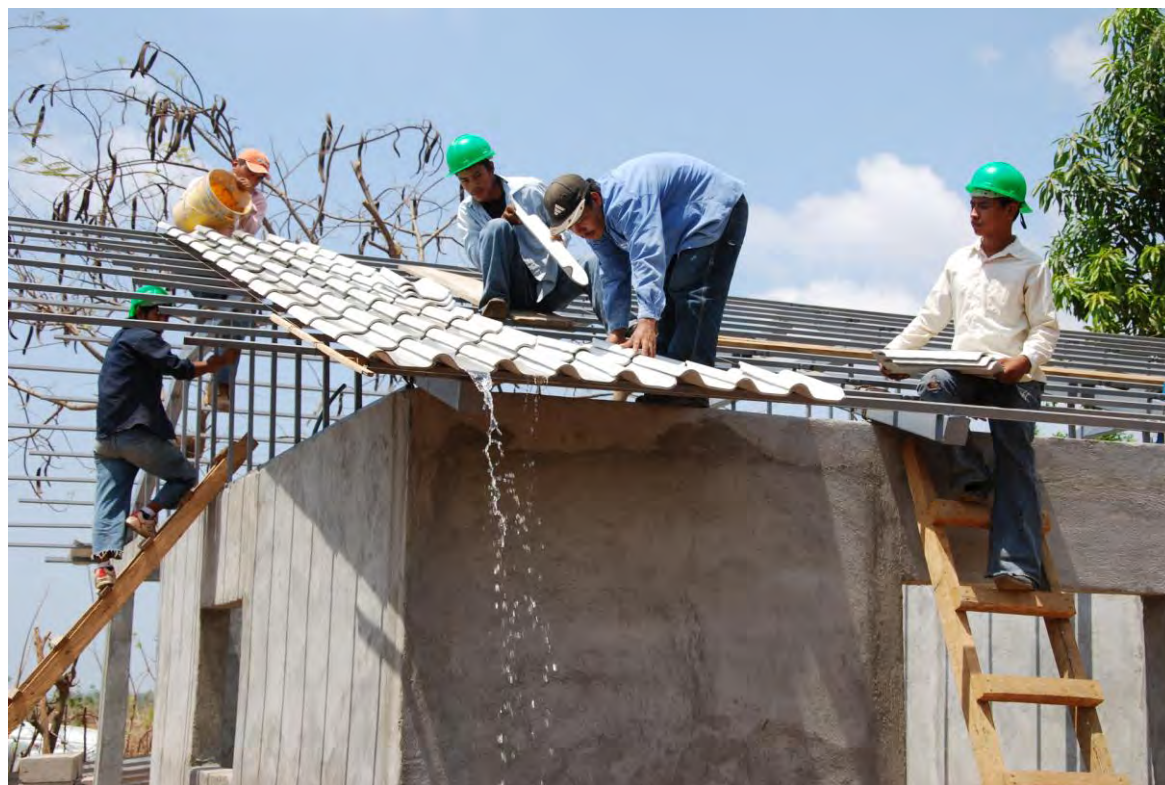
Colocación de una cubierta de TMC en la Comunidad El Triunfo (Champerico, Guatemala)
