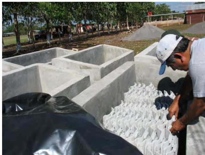
Operario colocando tejas para su curado
