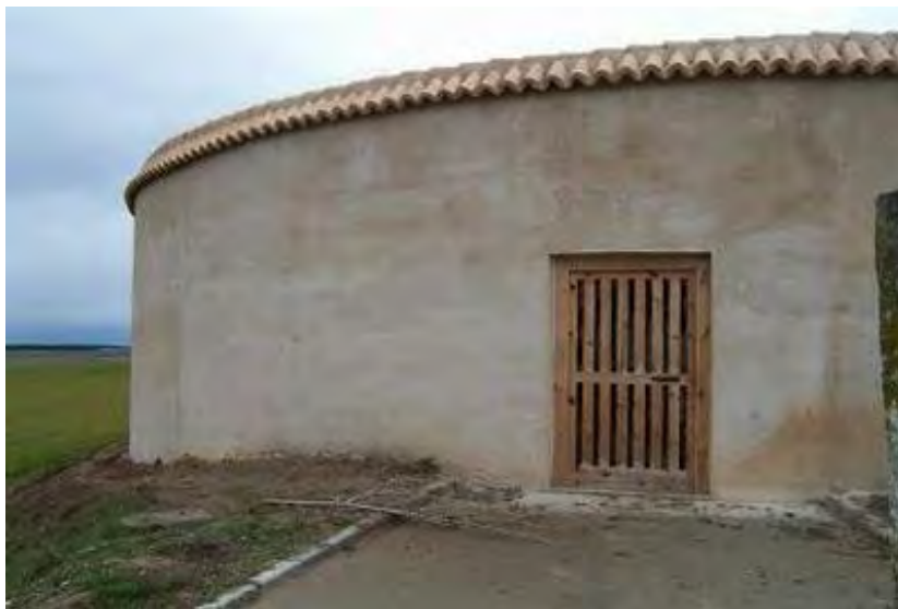
Palomar construido con muro de tapial
