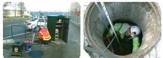
Montaje de la sección de control en la cuenca de "Los Rosales" en A Coruña (2008)
