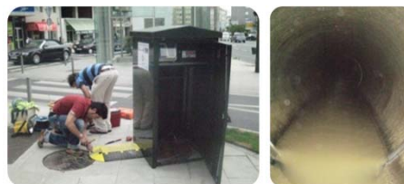
Montaje de la sección de control en la cuenca del "Ensanche" en Santiago de Compostela (2008).
