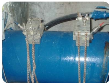
Caudalímetros Panametrics PT 868 instalados en tubería y TinyTag para almacenamiento datos
