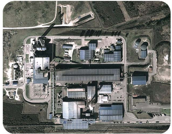
Vista aérea de la planta de Sogama
