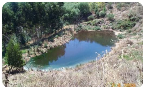
Balsa que recoge los lixiviados que escurren del vertedero de Orense
