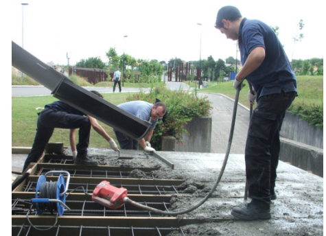
Hormigonado de la prelosa.
