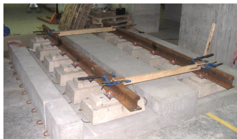
Ensamblado de un tramo de vía.
