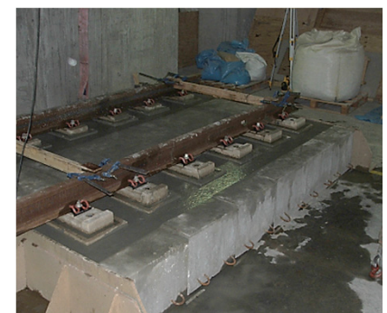
Acabado final tras el vertido del hormigón autocompactable
