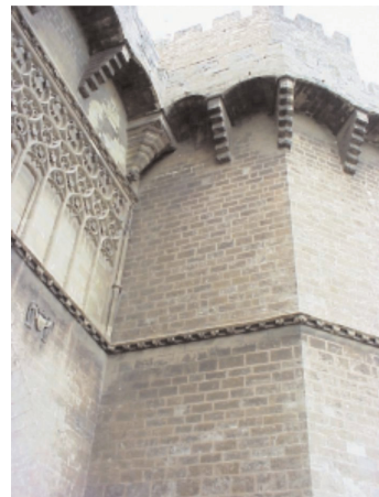
Imagen 1: Decoración Exterior: Imposta, tracería ciega y canes de apoyo de la barbacana
