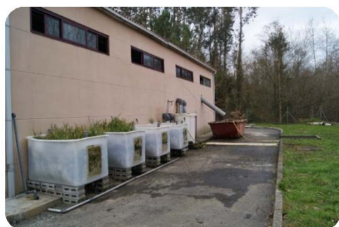
Sistema experimental de humedales artificiales: vista general
