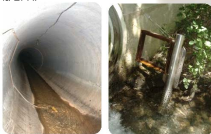
Sección de control "Fontiñas". Colector 1500 mm e instrumentación de medición de caudal
